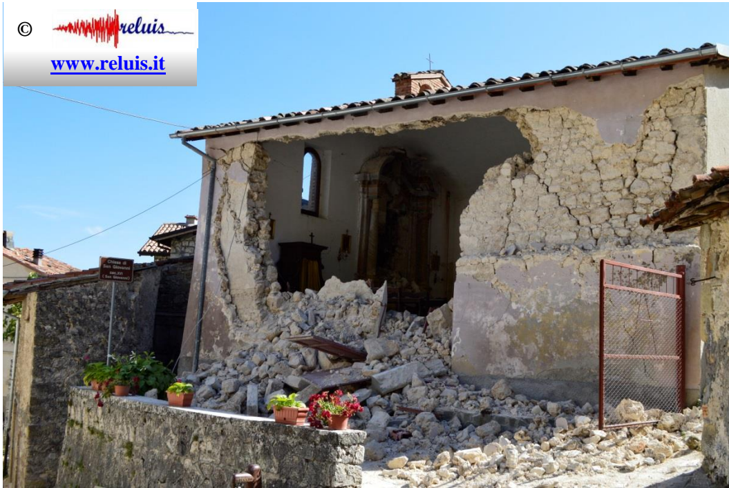
Chiesa - San Giovanni (frazione di Accumoli) Meccanismo di collasso della parete fuori piano.
